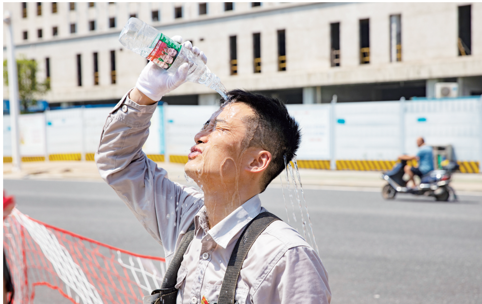
▲带电作业现场,返回地面的刘杰将没有喝完的水浇在头上降温。
