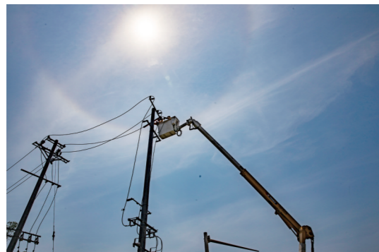
▲用电负荷攀高,冒着烈日抢修故障是电力工人的常态。
