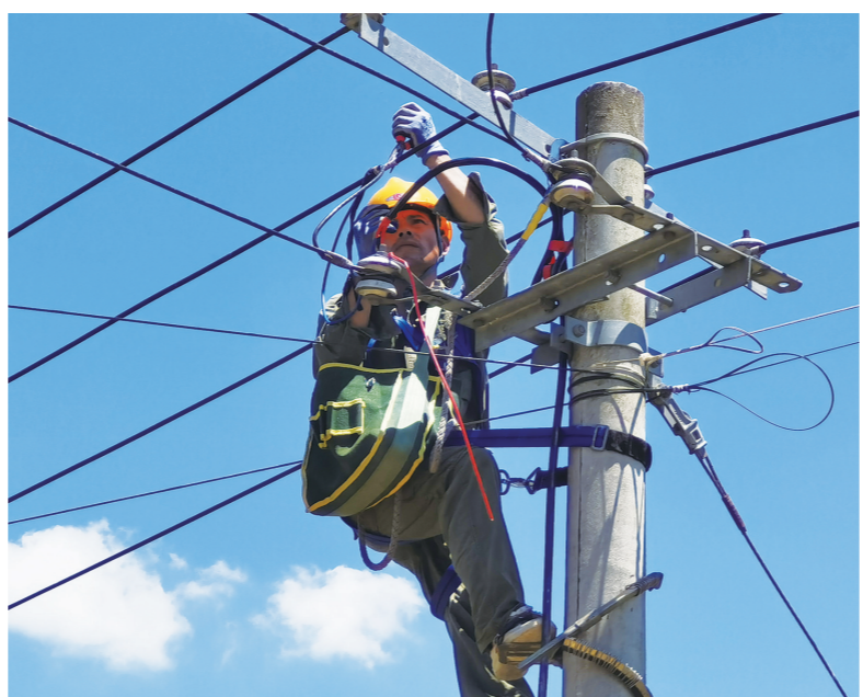
天元区雷打石镇新龙村,供电所工作人员正在改造农电抗旱专线。记者/杨如 摄
