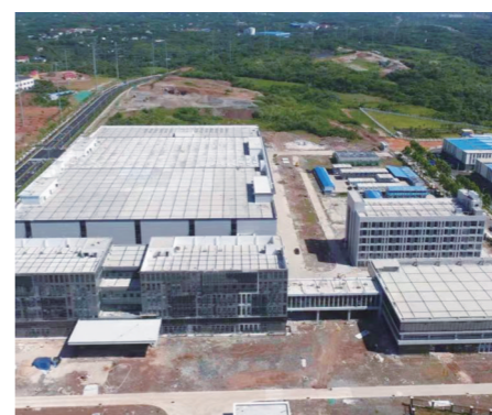
国创越摩先进封装项目建设现场。通讯员/甘敏 供图
