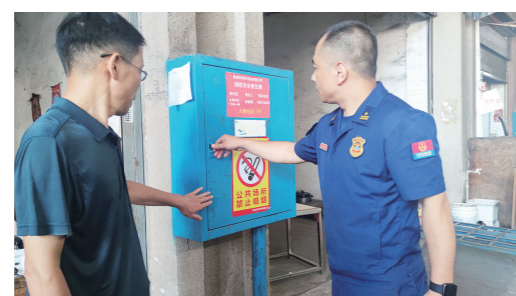
▲消防部门在检查市场的消防设施。记者/杨凌凌 摄
