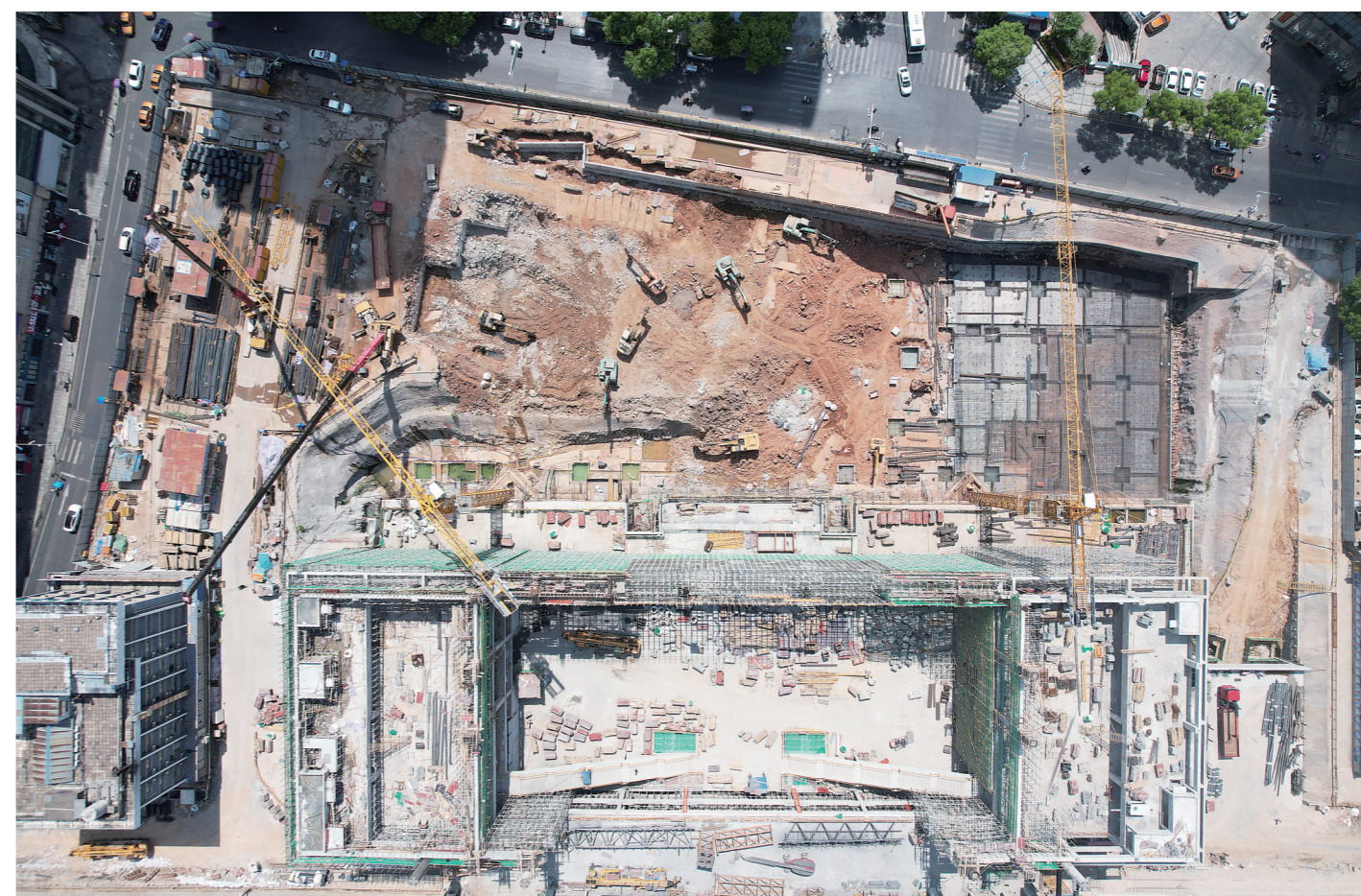
▲计划于年底开通运营的株洲火车站西站房目前建设进度如何? 8月14日,记者深入项目现场了解到,尽管目前高温难耐,但项目各环节仍按计划进度推进,预计年底具备开通条件。图为西站房施工现场。施工方供图
