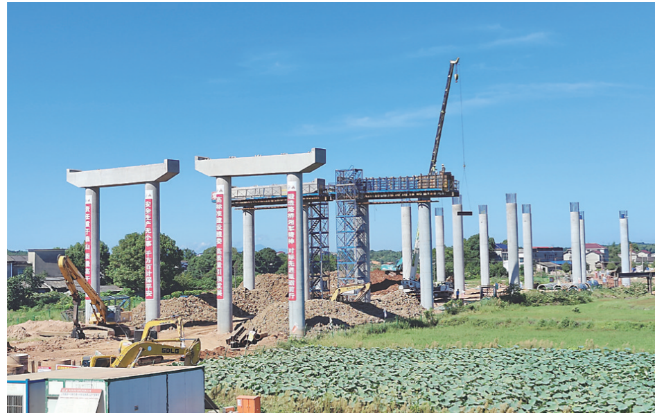
▲醴娄高速湘江特大桥施工现场。 记者/徐健浩 摄
