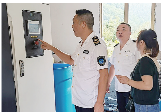
执法人员检查水厂现场。通讯员供图
