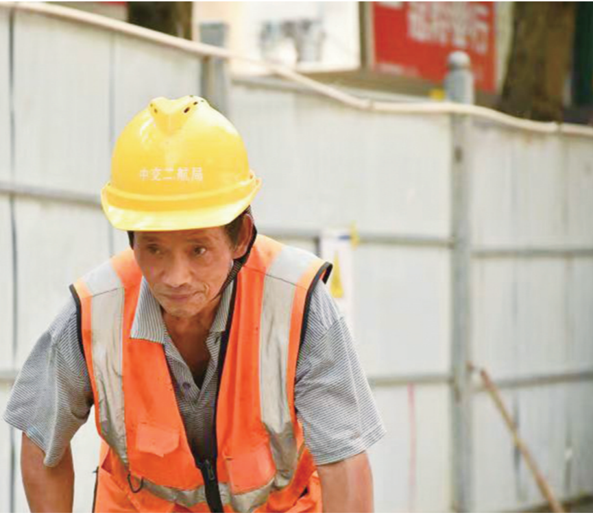
中交二航局渌口水环境综合治理项目现场，工人在施工。株洲日报全媒体记者/吴楚/摄
