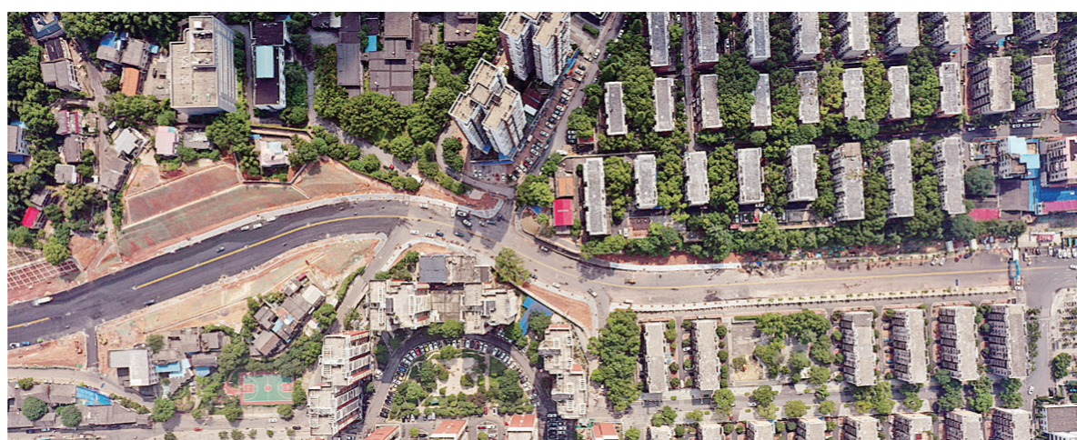
即将改造完成的田心路 株洲日报全媒体记者/周嵩 通讯员/谭洪汀 摄
