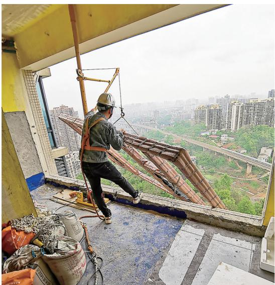
门窗安装工通过吊机把沉重的门窗吊上高楼。
