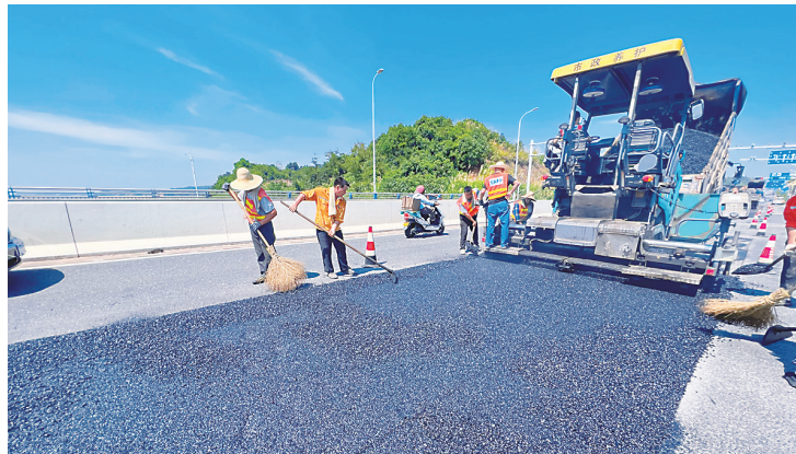
▲ 涠口大桥上,市城管局市政工程维护中心的队员们“趁热”摊铺沥青。
