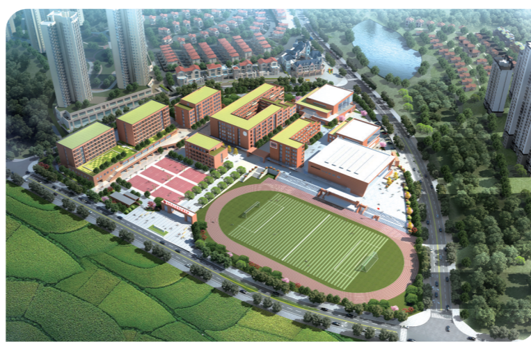
▲株洲市二中青龙湾中学校区已全面开工建设。
