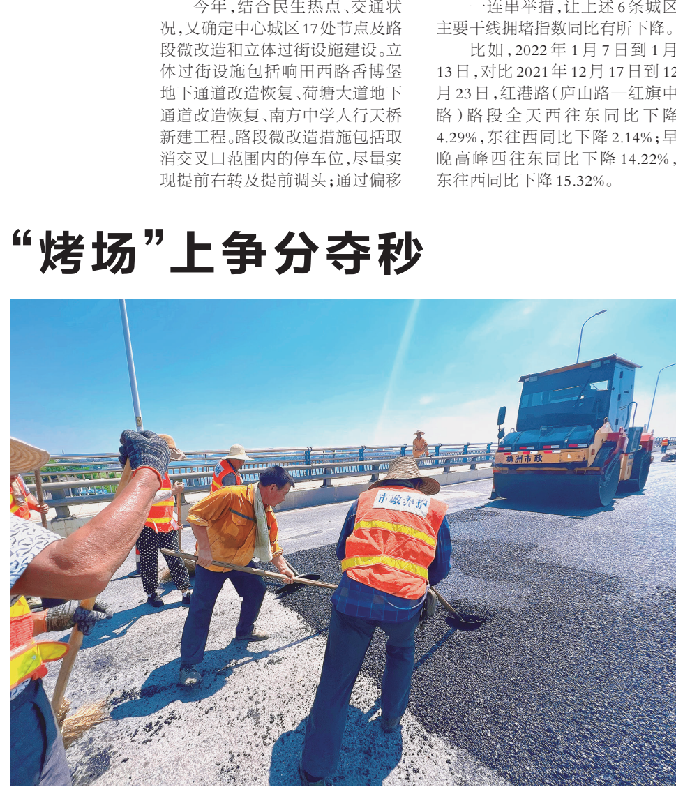
渌口大桥上,市城管局市政工程维护中心的队员们“趁热”摊铺沥青。株洲日报全媒体记者/伍靖雯 摄
