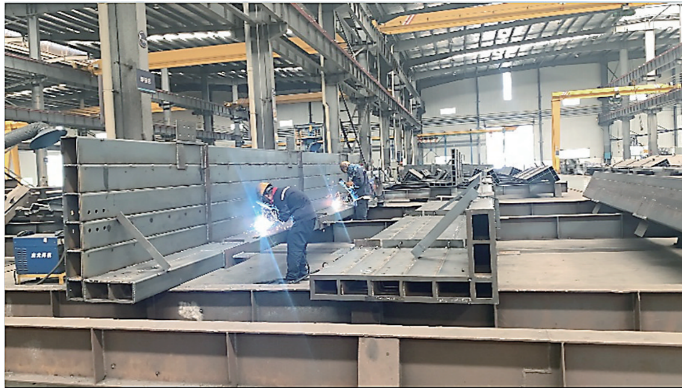
中天杭萧厂房内焊花飞溅
