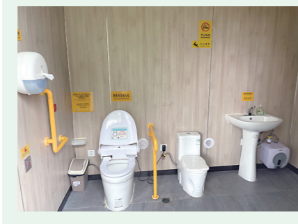
▲设施完备的建宁驿站无障碍卫生间。伍靖雯/摄
