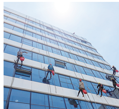
▲“蜘蛛人”顶着烈日清洗高楼外墙。 记者/马文章 摄
