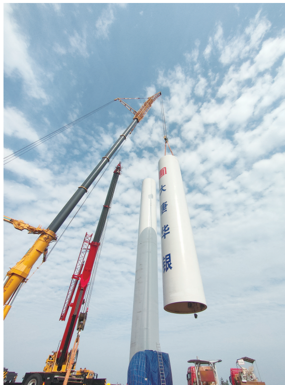
醴陵市明月山风电场建设现场。
