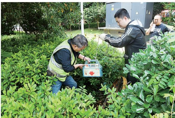
探测水管走向和深度。
