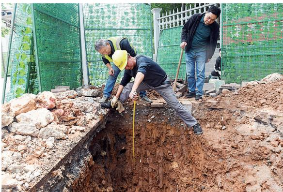
配合施工人员对暗漏点开挖。
