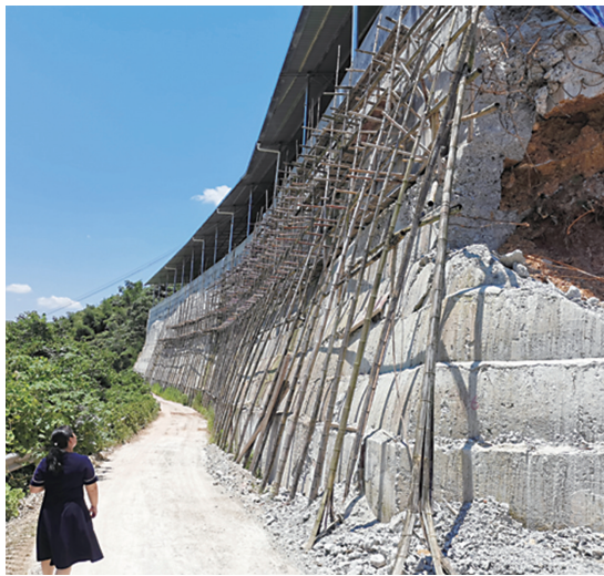
▲护坡紧邻通往大桥湾组的村道,高度有十多米。记者/姚时美 摄
