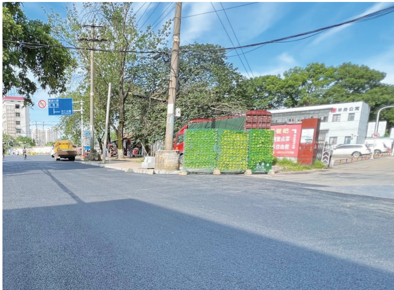
全新的沥青路面。记者/伍靖雯 摄
