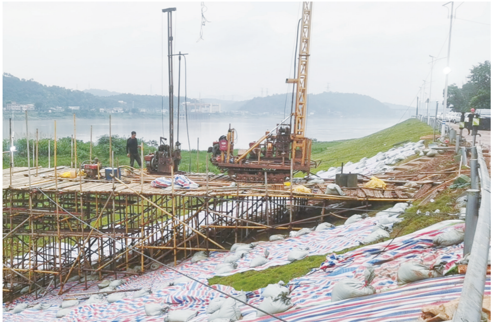
抢险施工现场。株洲日报全媒体记者/俞强年 摄
