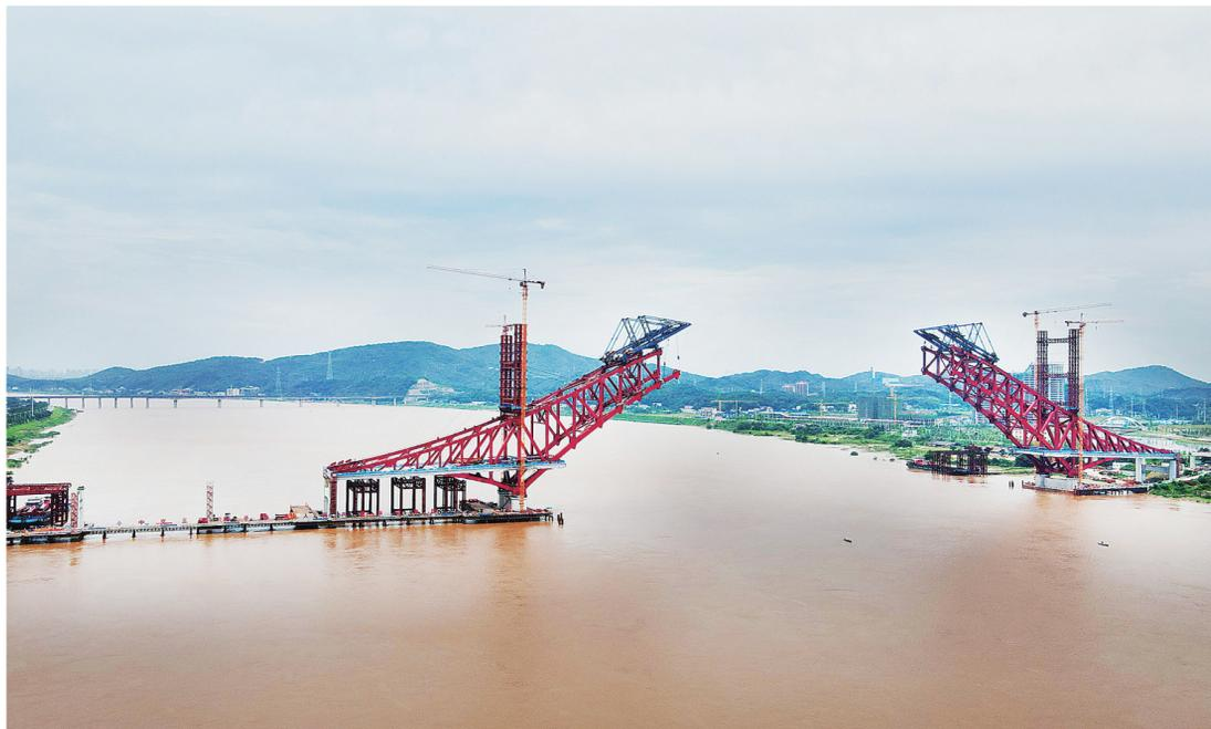
▲6月27日,清水塘大桥水下作业告一段落,目前正在进行大桥主拱和扣塔的施工。据介绍,为大桥主拱提供支撑的两座扣塔将在下个月完成主体建设,届时江面将矗立起两座140米高钢铁之塔。作为我市横跨湘江的第八座桥梁,清水塘大桥将成为连接石峰区、天元区的新动脉,可有效地加强轨道交通科技城、清水塘生态文化科技新城、栗雨工业园以及武广新城的紧密联系,联动效应显著。图为项目建设现场。
