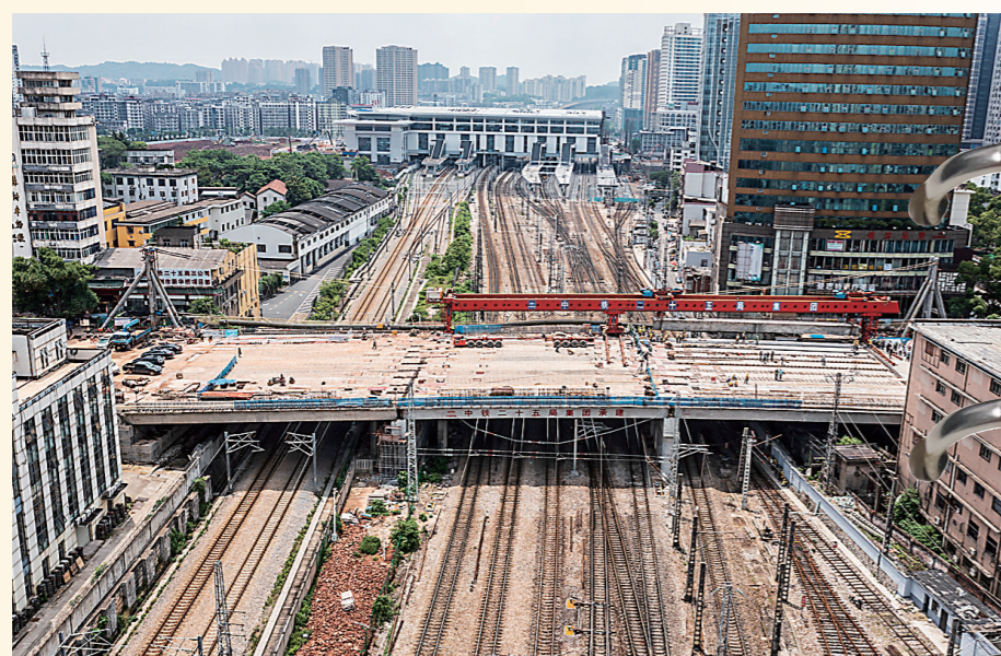
2022年5月21日,新华桥36片箱梁全部架设到位。 株洲日报全媒体记者/李翰 摄
