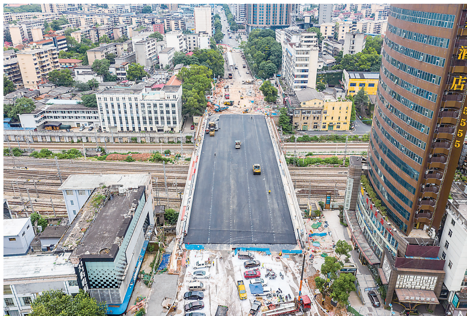
▲6月16日，记者在项目现场了解到，新华桥桥面的沥青铺装工作已展开，按计划当天完成。图为沥青铺装现场。 株洲晚报融媒体记者/廖明 李翰 摄影报道
