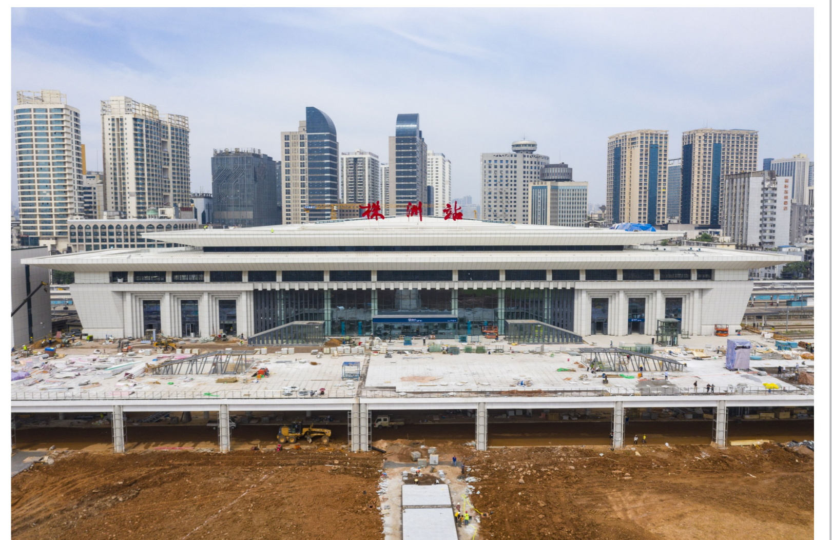
▲6月30日,株洲火车站东站房将全部建成,达到开通运营条件。6月15日,记者探访项目施工现场,提前一睹百年老站的新面容。图为火车站东站房外景。
