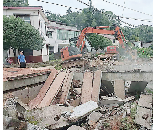
白关镇拆违现场。 通讯员 供图
