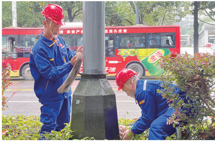
▲工人们路灯杆进行清洗除锈。记者/伍靖雯 摄
