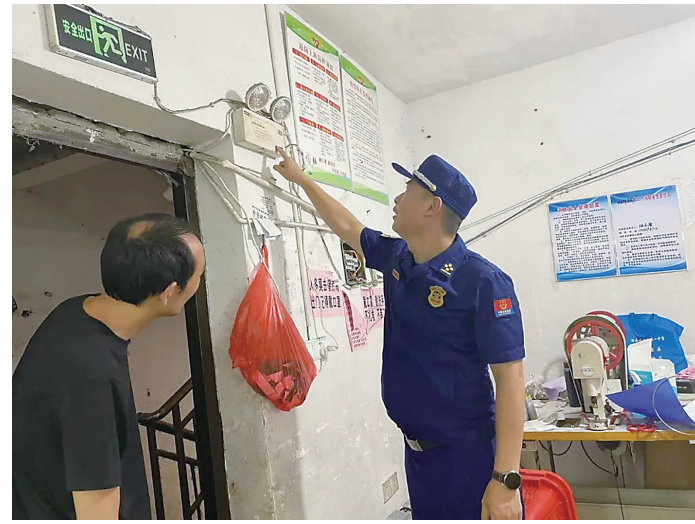
▲检查人员检查服饰加工厂应急灯是否能正常使用。通讯员供图
