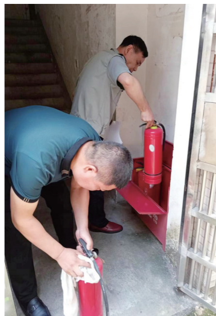
▲工作人员在维护消防器材。记者/刘平 摄
