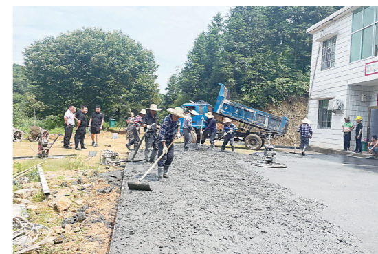
▲三门镇黄田村,施工人员正在修路。记者/杨如 摄
