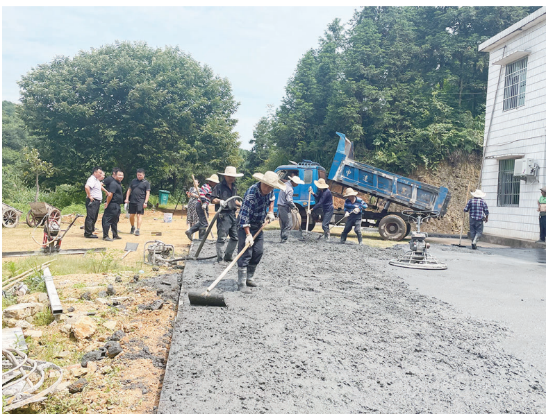
现场正在进行路面硬化施工。记者/杨如 摄
