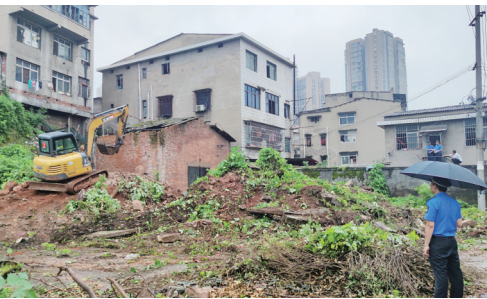
▲龙泉街道龙泉村,无证危房被拆除。 记者/杨凌凌 摄
