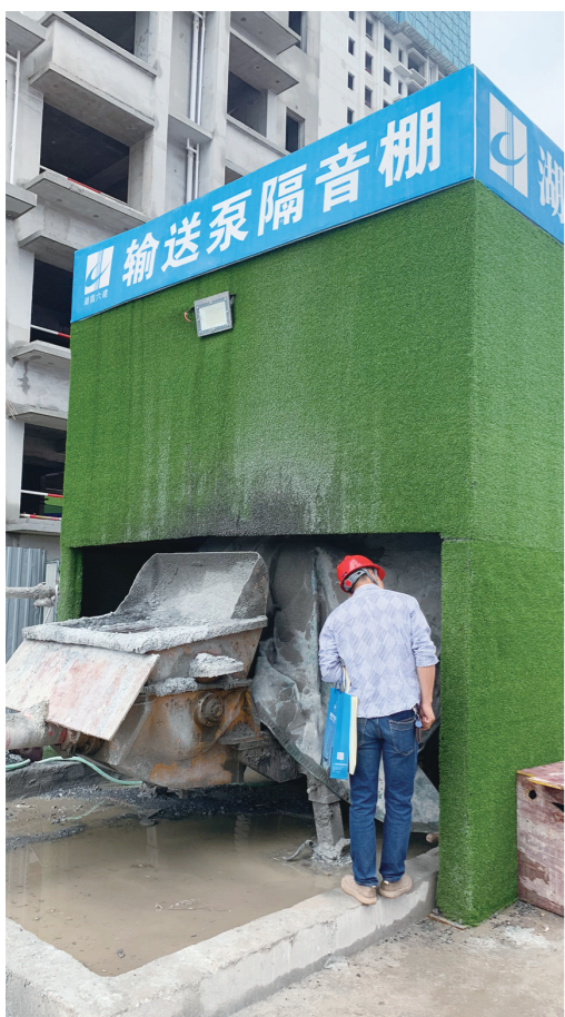
建筑施工企业开展施工噪音检查。 吴楚/摄
