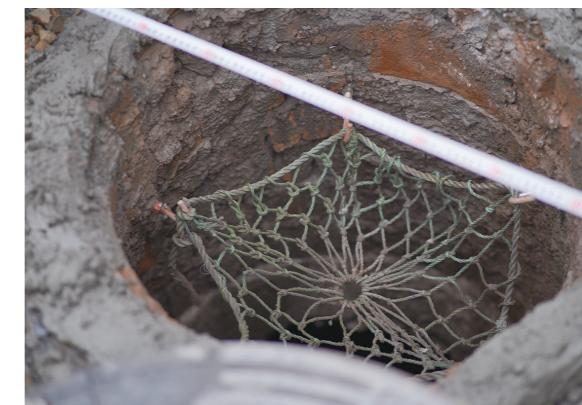
▲两年前,市市政工程维护中心在窨井内安装的防坠网,依旧完好无损 伍靖雯/摄
