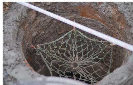
▲两年前,市市政工程维护中心在窨井内安装的防坠网,依旧完好无损 伍婧雯/摄
