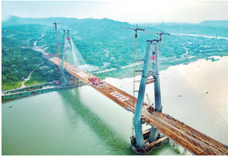
▲新建川南城际铁路宜宾临港长江大桥顺利合龙。
