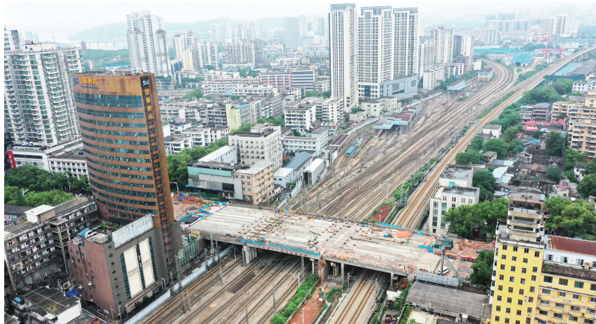
▲5月31日,航拍施工现场。株洲晚报融媒体记者/谢慧 摄
