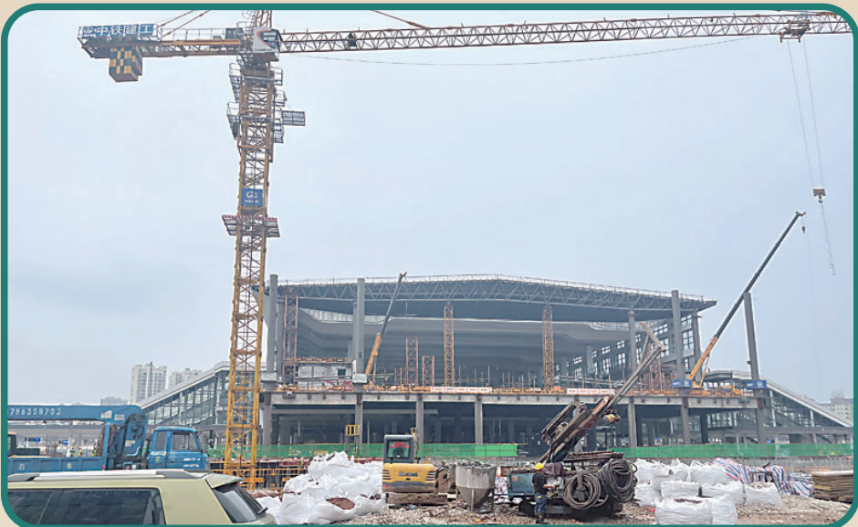
▲正在改扩建施工的株洲火车站。伍靖雯/摄
