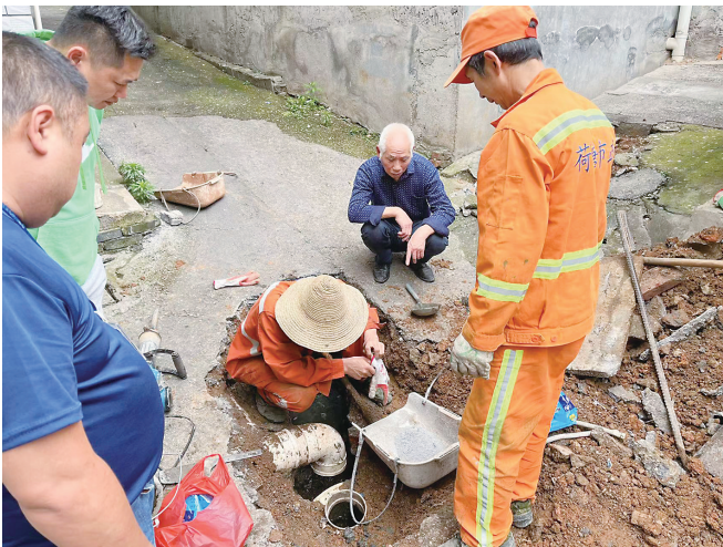
▲施工人员正在维修。记者/贺天鸿 摄
