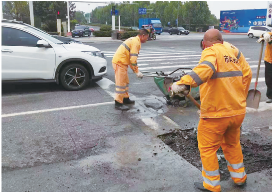
▲市政人员紧急施工处置。市政工程维护中心供图
