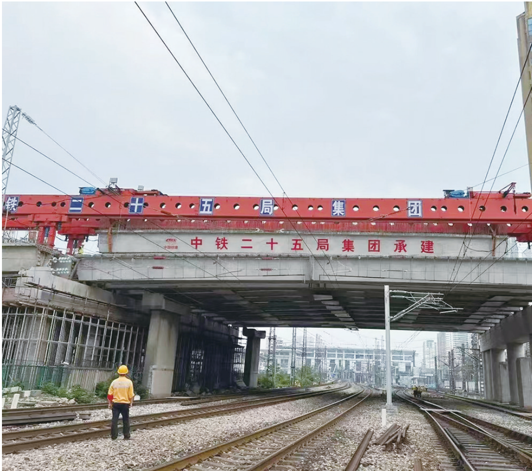
新华桥第二跨箱梁全部架设到位。 通讯员 供图
