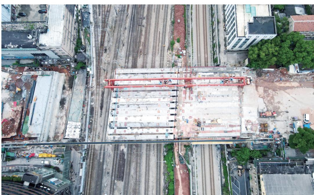
▲5月10日,记者从中铁二十五局三公司新华桥拆除重建工程项目部了解到,新华桥第二跨的12片箱梁,5月9日全部架设到位,新华桥桥梁主体已成桥三分之二。按计划,新华桥最后一跨的箱梁架设,将于5月14日开始。同时,新华桥连接线、智轨站、通信迁改等配套工程正按计划推进,确保顺利达成6月20日建成通车的目标。
