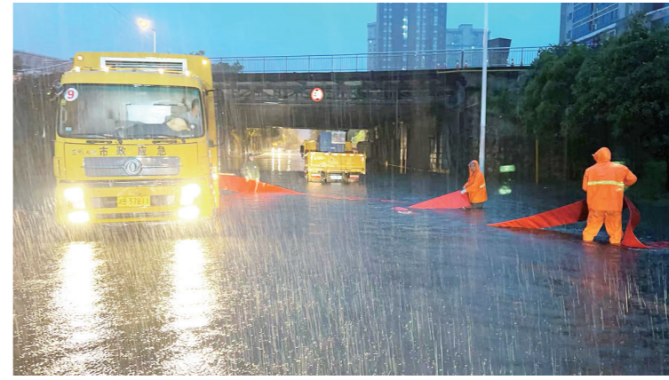
▲红旗南路跨石宋路桥下积水影响交通,市市政工程维护中心调派“龙吸水”设备抽水。通讯员供图
