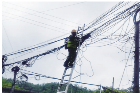
▲施工人员整治空中缆线。通讯员供图
