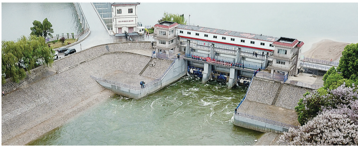
4月28日,山东省德州市四女寺枢纽南运河节制闸开启,对京杭大运河全线贯通补水(无人机照片)。
