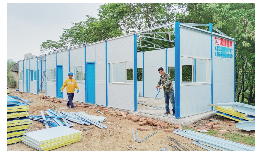
▲刚刚建好的板房被责令拆除。记者刘平摄
