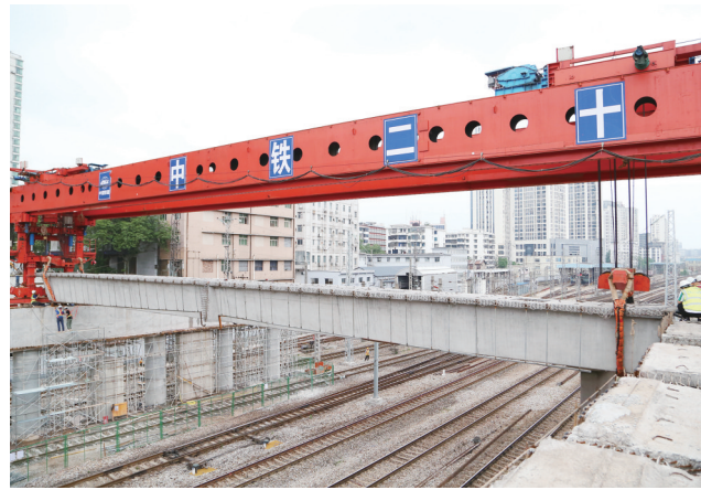
▲新华桥第二跨首片箱梁架设到位。通讯员供图
