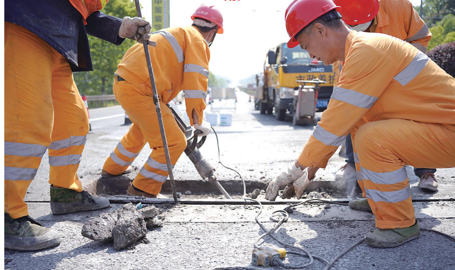
▲市政设施大中修及专项维修计划已敲定，相较往年，今年增加了不少新项目、新亮点。图为市市政工程维护中心队员们在石埠路桥维修桥梁伸缩缝。
