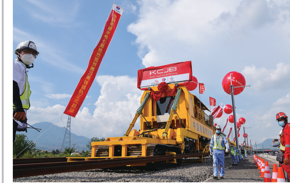
4月20日,随着第一根500米长轨在印度尼西亚爪哇省万隆县雅万高铁动车走行线顺利铺设,雅万高铁开始启动铺轨施工。雅万高铁是“一带一路”建设和中印尼两国务实合作的标志性项目。图为当日,工作人员在印度尼西亚万隆雅万高铁铺轨施工现场作业。新华社记者 徐钦 摄
