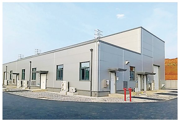
中国能建湖南火电承建的湘潭板塘110千伏变电站。 企业供图
