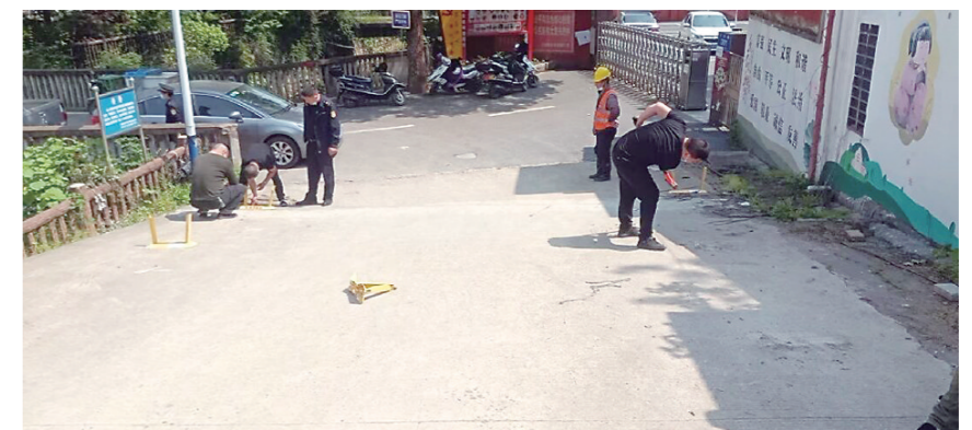
▲工作人员在拆除地锁。通讯员供图
